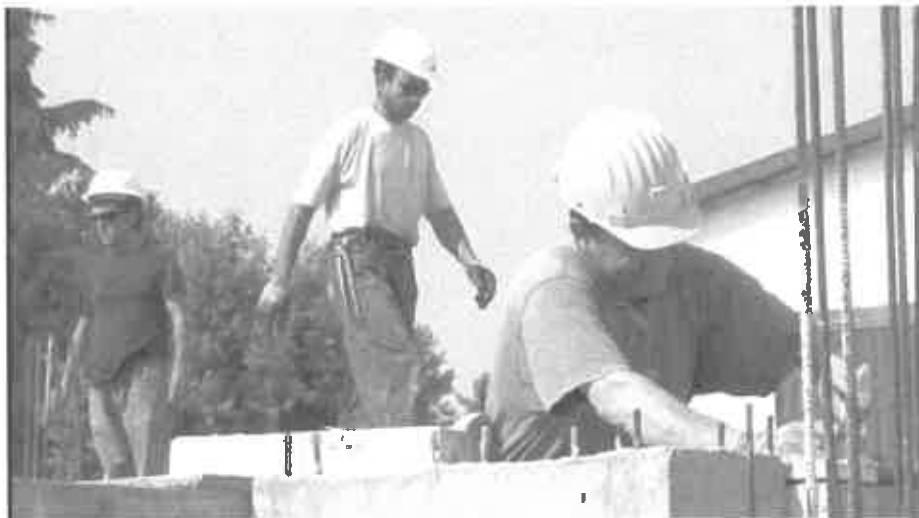
Gruppo di lavoro in un cantiere
