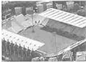
PIZZAROTTI: "IN CANTIERE L'IDEA DI UN PARCO DELLO SPORT AL TARDINI"
